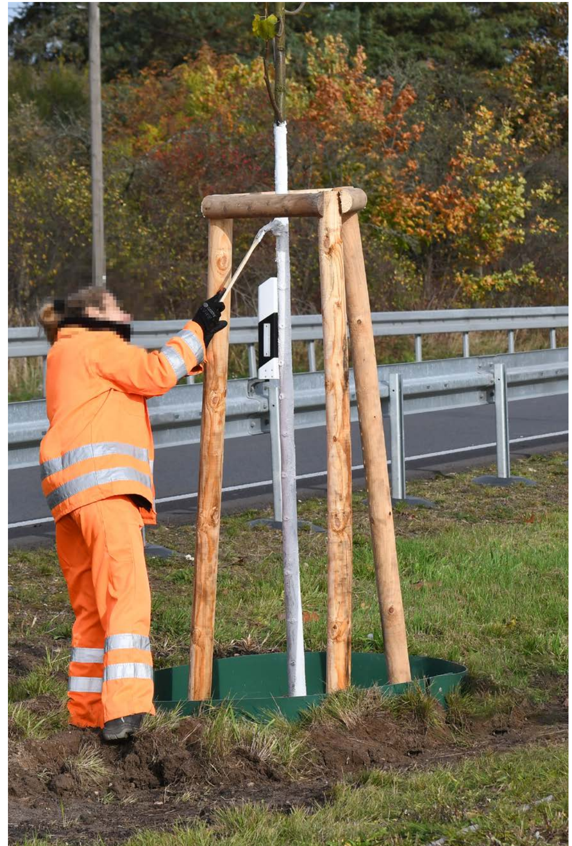
Baumarbeiten an der B246
