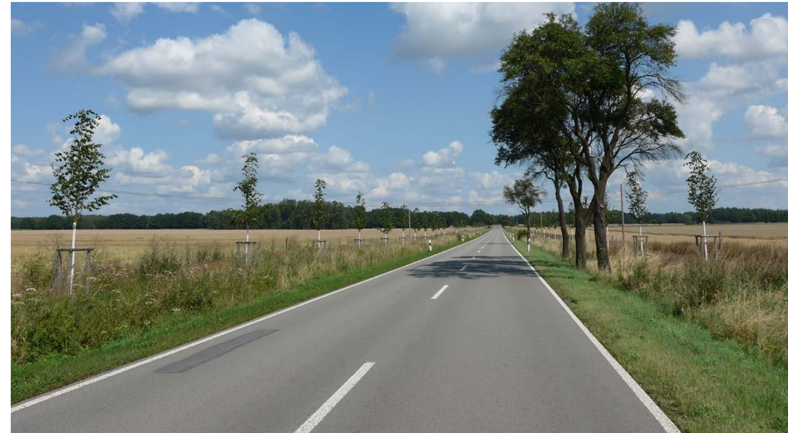
Ersatzmaßnahme an der L13 – Hinterpflanzen der Allee
