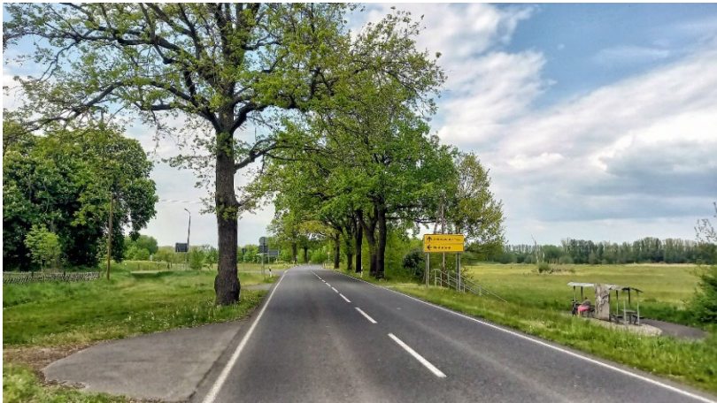
Abb. 2 und 3: Die Regelwerke ESAB und RPS führten bei Neupflanzungen bisher zu einem Sicherheitsabstand von 4,5 Metern zur Fahrbahn – oder zu deren Unterlassung. (Fotos: Hoch)
