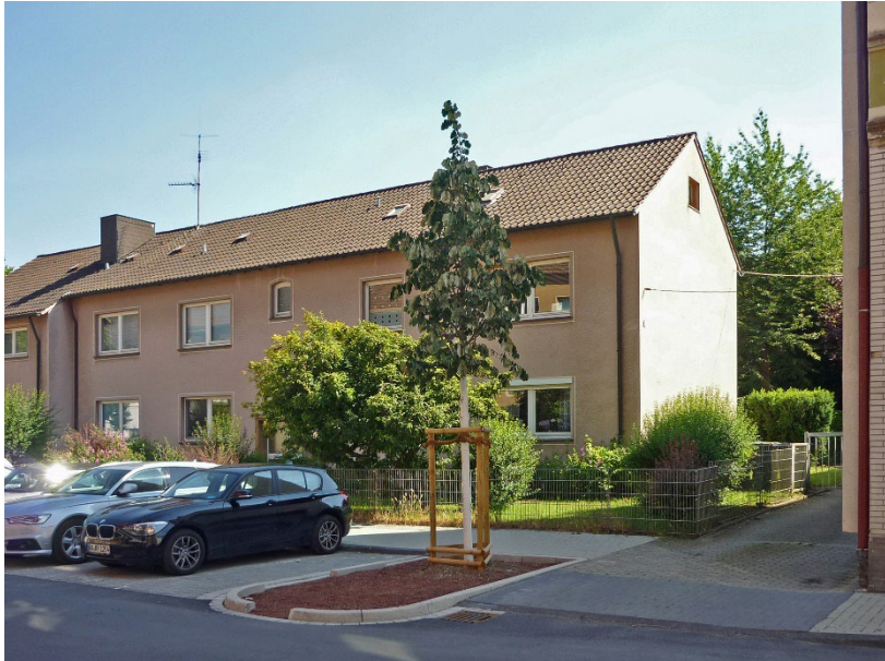
Abb. 1b: Weiteres Beispiel für einen nicht regelkonformen Baumstandort, bei dem Oberflächenabflüsse über die Straßenschulter in diesen einlaufen können (Foto: M. Streckenbach).
