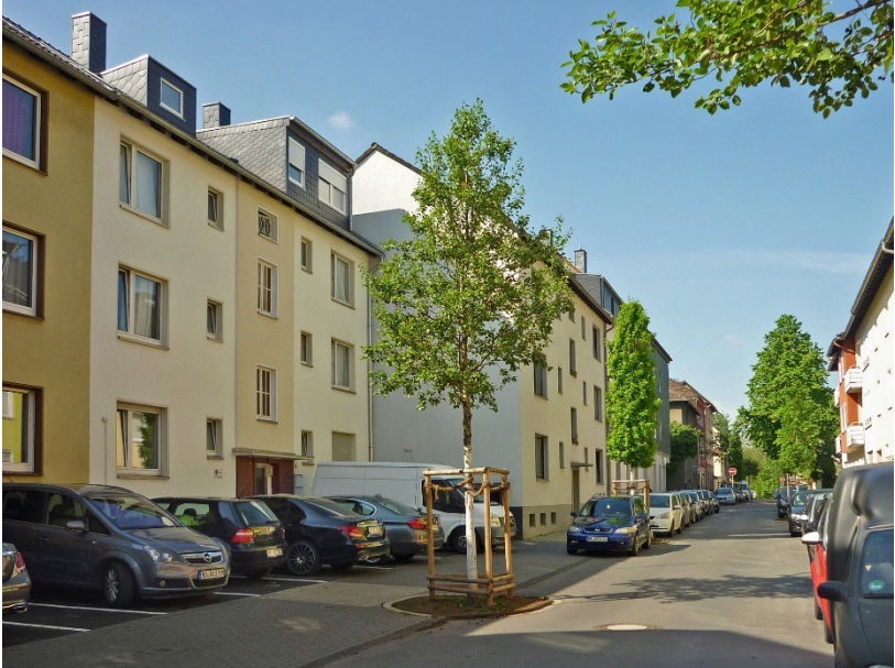
Abb. 1a: Beispiel für einen nicht regelkonformen Baumstandort, bei dem Oberflächenabflüsse über einen Sickerschacht in den als Rigole ausgestalteten Standort eingeleitet werden (Foto: M. Streckenbach).
